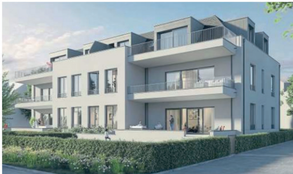
Weißer Putz mit Natursteinen: So soll der Neubau an der Jägerallee aussehen.
